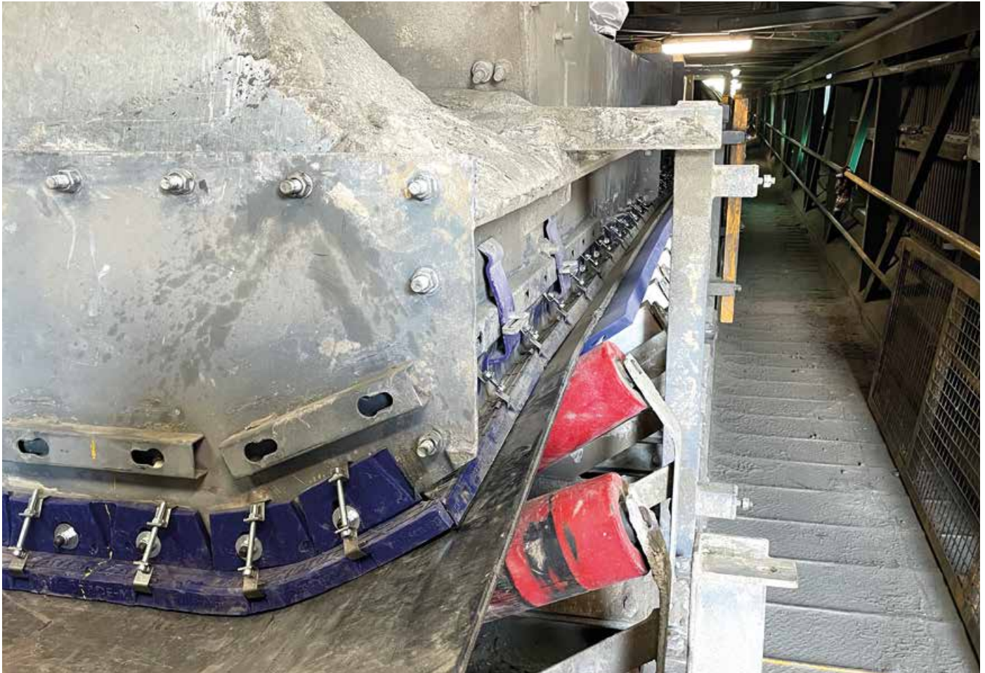
Höchste Abdichtungseffizienz mit der Essential Air Seal Staubschutzkombination, bestehend aus dem AirScrape, TailScrape und dem SureSupport
