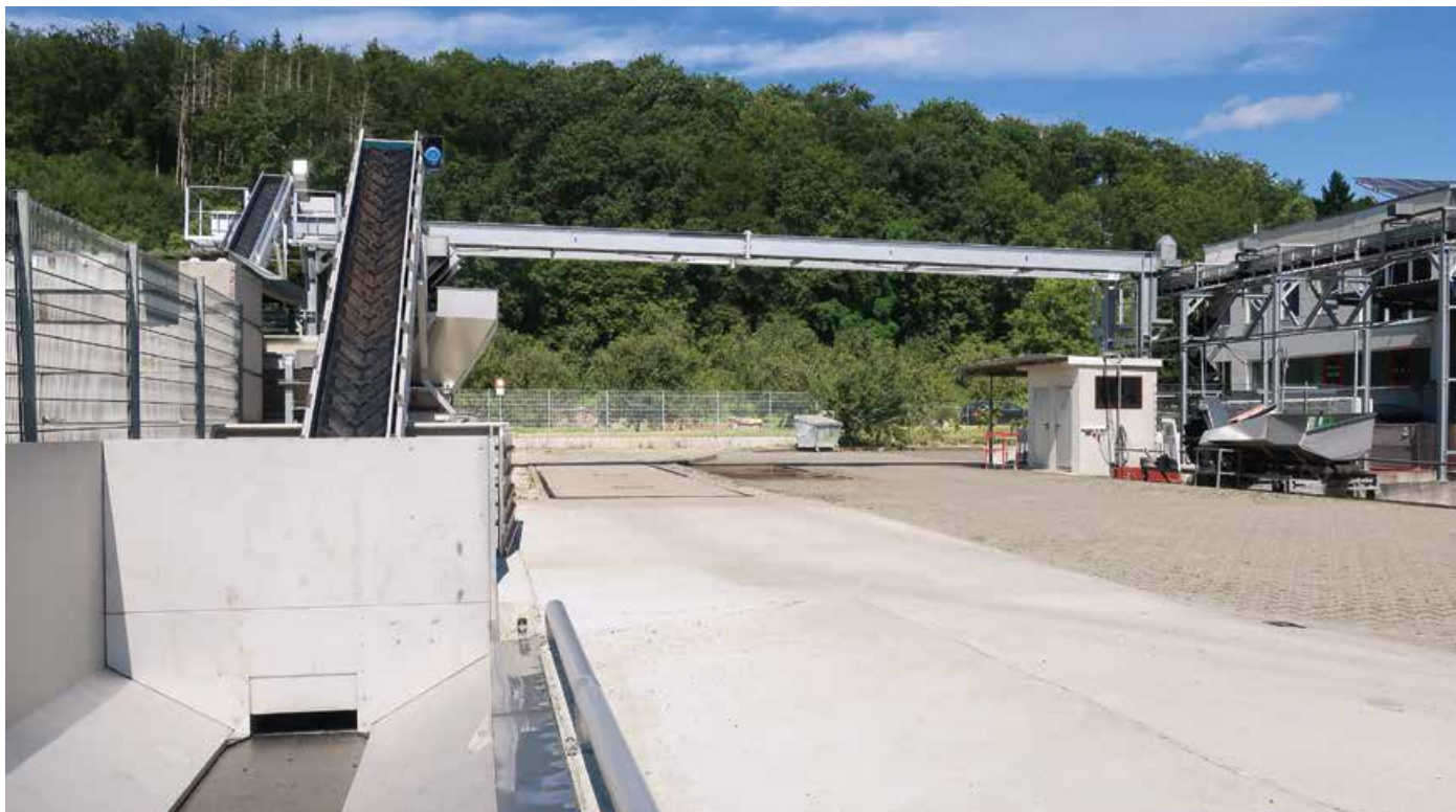
Damit die Anlieferung schnell und möglichst ohne Staus erfolgt, kann das Annahmehand bis zu 300 Tonnen pro Stunde aufnehmen und weiterfördern
